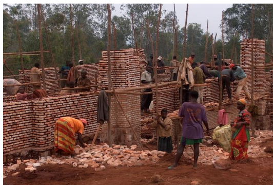
Le chantier progresse
