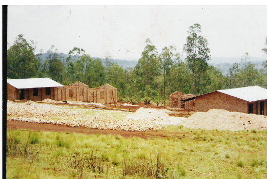
Le site en construction
