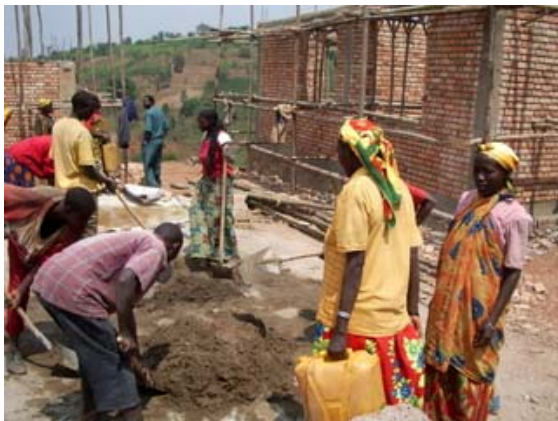
Participation active de la population locale aux travaux de construction.
