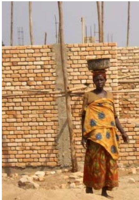
Les femmes sont intégrées et impliquées dans la construction.
