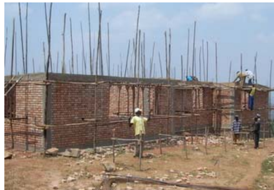
Le chantier à mi-août 2009
