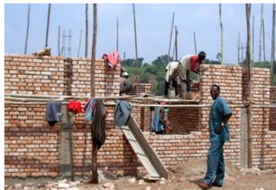
L'administrateur de la commune de Gatara, Mr Nyabenda Melchior, sur le chantier.
