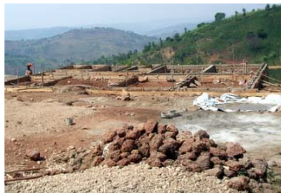
La fondation de la maison du futur responsable de centre de santé.
