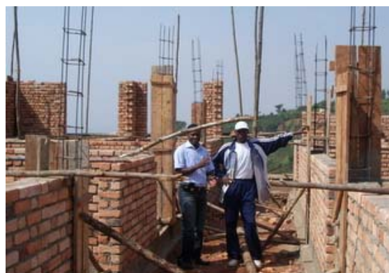
Jean Marie, membre EduSaT, visite le chantier avec l'administrateur de la commune de Gatara, Melchior Nyabenda.
