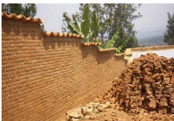
Clôture du lycée de Gatara.
